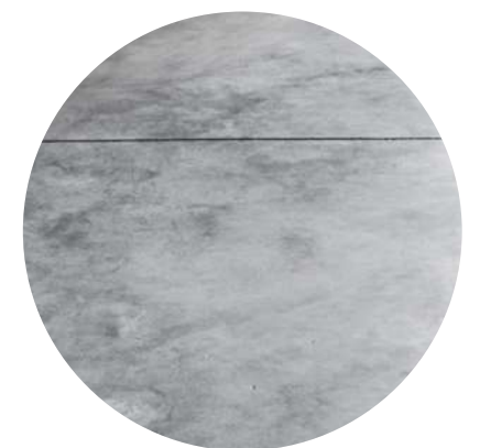
Pavimentazione in cemento lisciato
